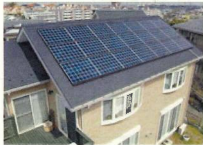
三重県では、京セラ株式会社 三重伊勢工場でパネル組み立て
