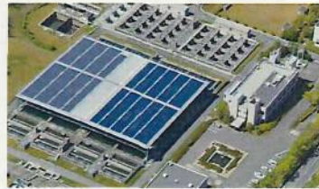
三重県企業庁播磨浄水場のソーラー (360kW)
